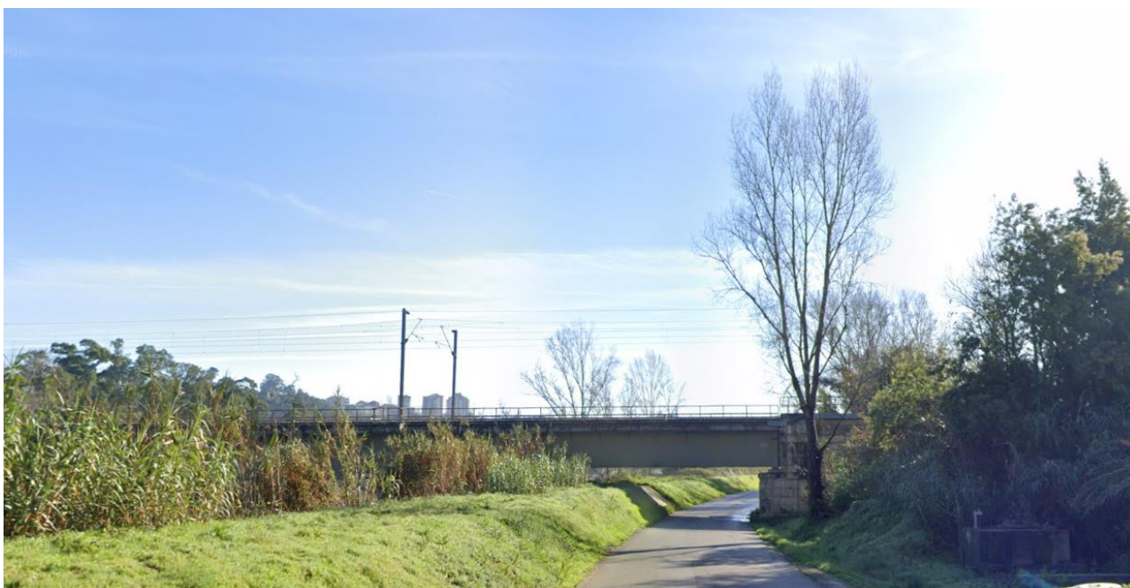
Fotografia 6.19 - Fotografia tirada a partir da Estrada do Rio para o início da existente Ponte sobre o Mondego da Linha do Norte, onde o Flyover de Bencanta proposto se irá desenvolver; orientada a este. (Google Earth, janeiro de 2022)
