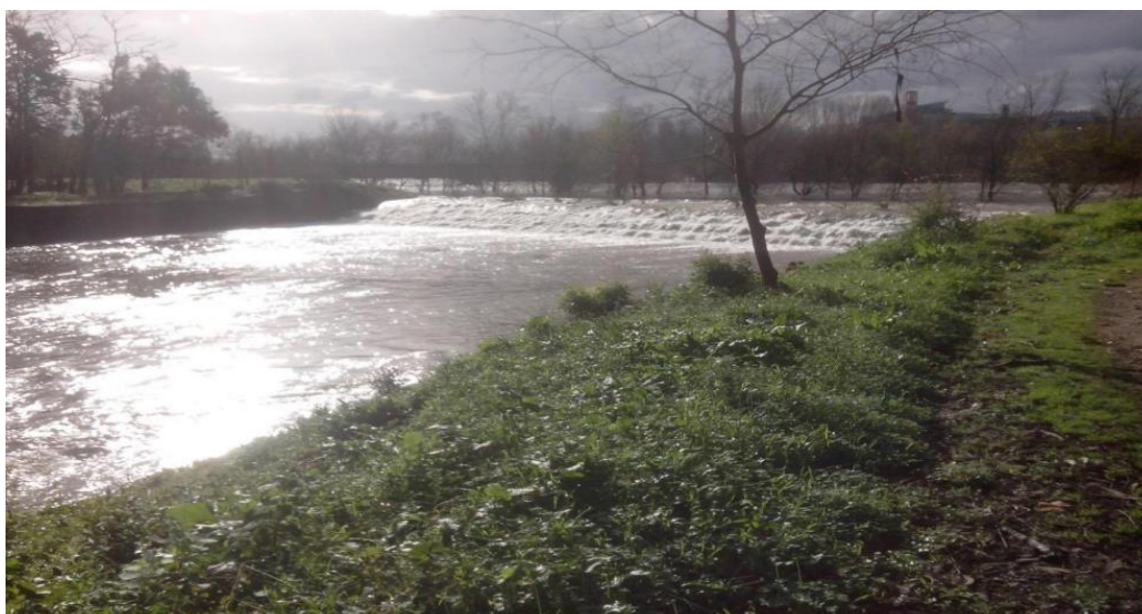
Fotografia 6.1 – Descarregador fusível do Choupal (cheias de 2016) (Fonte: “Aproveitamento hidráulico do Mondego e a Redução do Risco de Inundação do Baixo Mondego”, José Manuel Proença)
