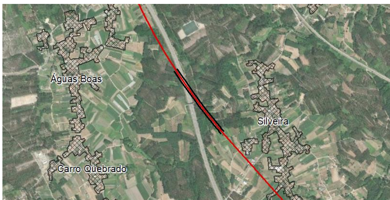
Figura 6.42 - Vista aérea da zona onde ocorre o Viaduto sobre a A1/IP1 entre o km 8+225 e o km 8+864 da Variante de Oliveira do Bairro (V.OB.2), sendo possível identificar predominância de manchas associadas à produção agrícola e silvícola, assim como as principais povoações potencialmente sujeitas a elevados níveis de intrusão visual na envolvente. (Fonte: produzido em ArcMap)
