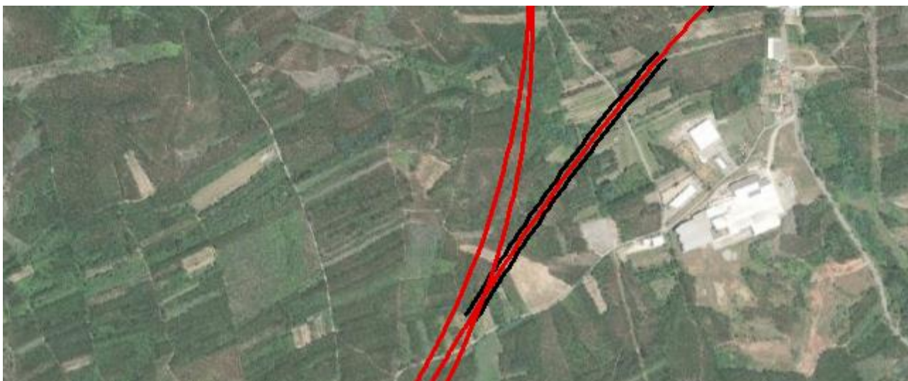
Figura 6.24 - Vista aérea do Viaduto de Morais (Eixo 3.1) onde é possível identificar a predominância de manchas associadas à produção florestal, a pouco expressiva produção agrícola na várzea e ainda a presença de áreas industriais na envolvente. (Fonte: produzido em ArcMap)
